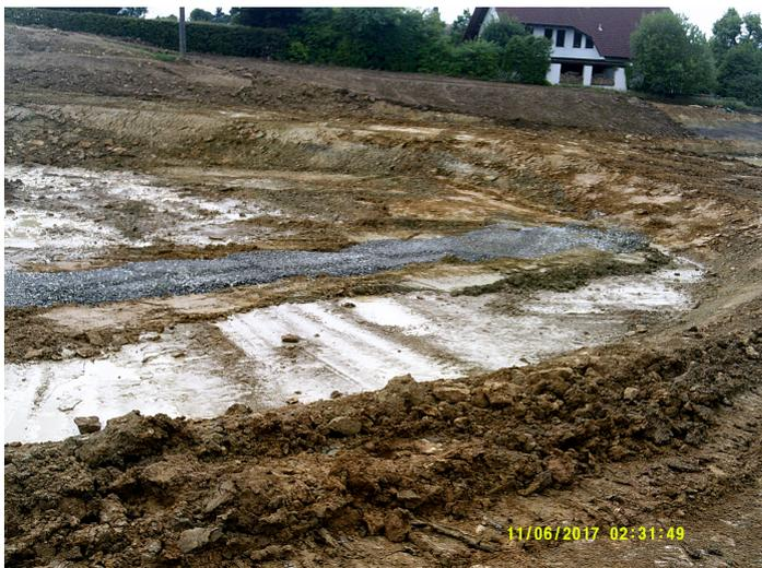
Plan2o hat mitgeteilt, dass Kiespackungen als konstruktive zusätzliche Maßnahme in die Regenrückhaltebecken eingebracht wurden. Diese sollen entlang des Wasserlaufs die Versickerung unterstützen. Sie wurden entsprechend der ausgeschriebenen Leistung ausgeführt:
