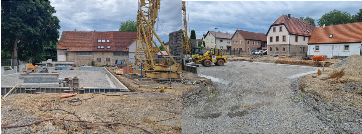
Der Aushub für das Fundament musste zwischen den beiden Sportplätzen zwischengelagert werden. Nach der Beprobung kann entschieden werden, bei welcher Deponie der Aushub entsorgt werden kann.
