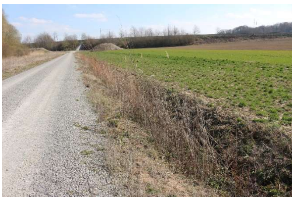
7: Graben mit anschließender Wiese
