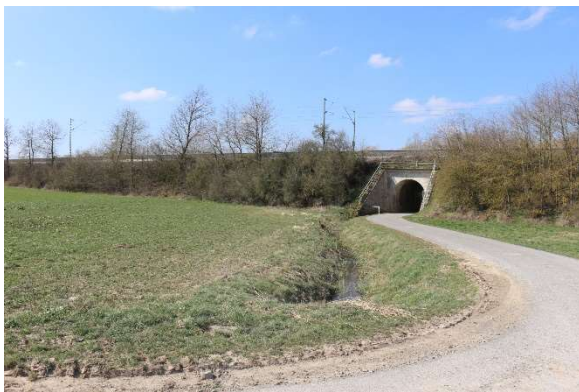
11: Bahnunterführung, Graben mit Wiese
