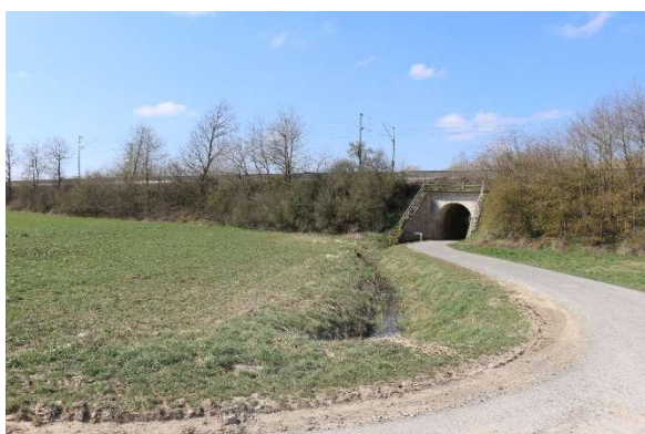
11: Bahnunterführung, Graben mit Wiese
