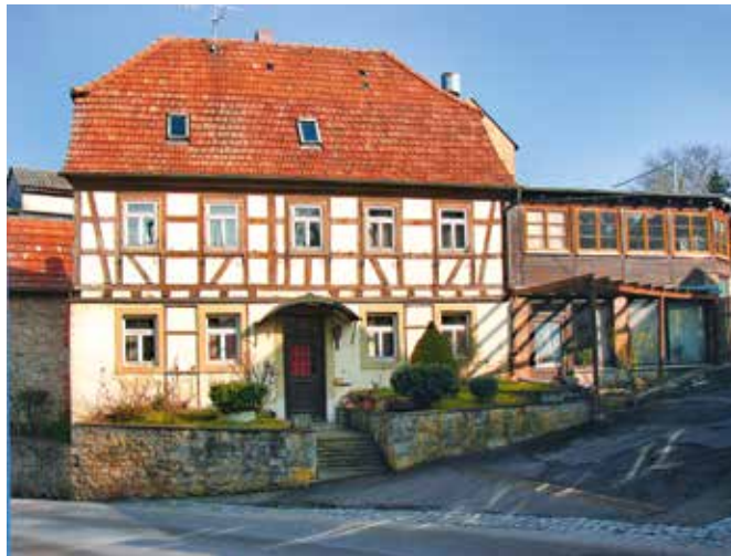
Uengershausen, Fachwerkbau von 1816.
